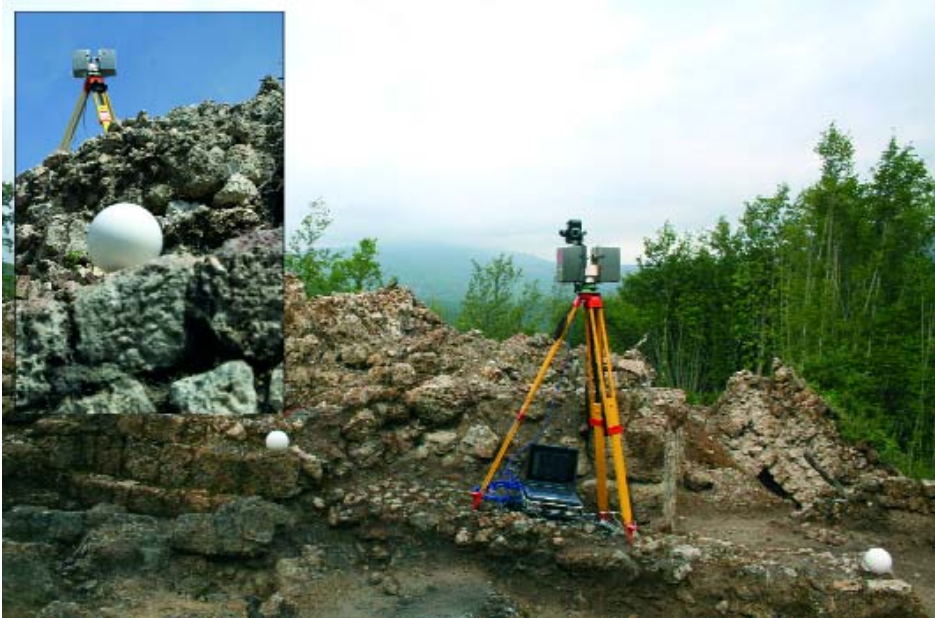
Fig. 6a. (Sopra). Ripresa dello scanner laser Faro LS 880 HE80.
